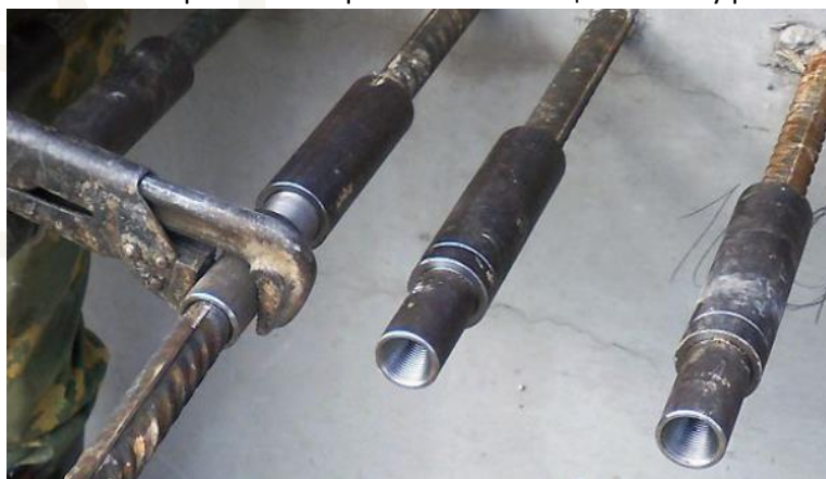
Фото. Применение резьбовых позиционных муфт.
